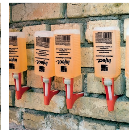
6 Injektionsflüssigkeit dringt in das Mauerwerk
