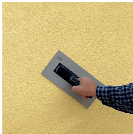
1 Aufbringen eines Oberputzes
