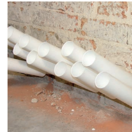
4 Trichter zum Einbringen der Horizontalabdichtung
