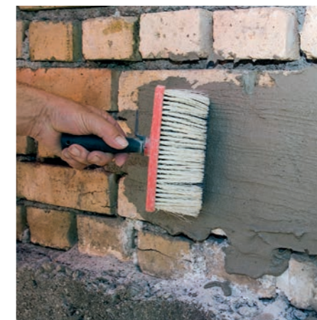
8 Abdichten mit Dichtschlämme
