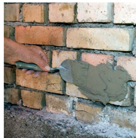
7 Löcher mit Beton- und Reparaturspachtel verschließen
