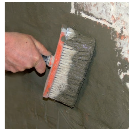
5 Auftragen der Dichtschlämme
