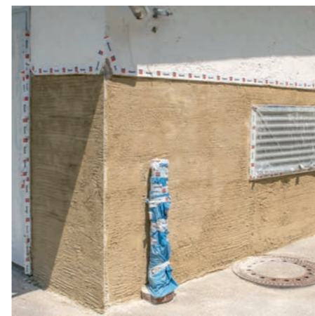
7 Ausgetrocknete erste Sanierputzlage
