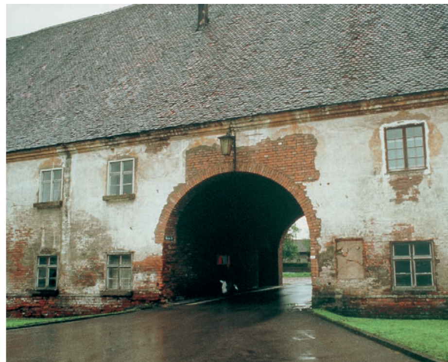
Egal ob Ihr Projekt die Verschönerung eines Wochenendhäuschens oder die Sanierung einer Klosteranlage ist ...
