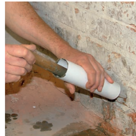
3 Einbringen der Dichtschlämme bzw. Mauer- und Putzmörtel
