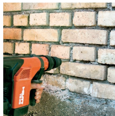
1 Setzen von Bohrlöchern
