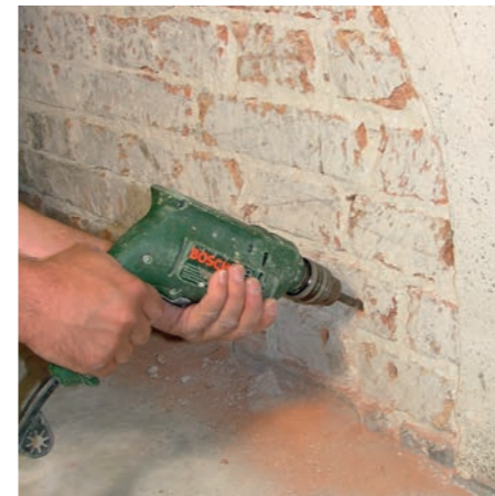
2 Bohrlöcher setzen
