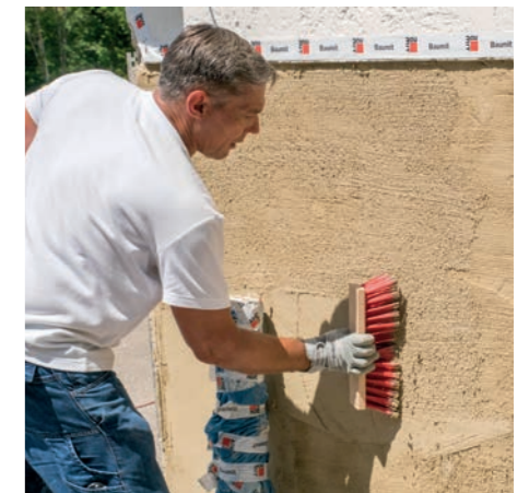
6 Aufrauen der ersten Sanierputzlage
