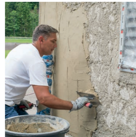
4 Aufziehen des Sanierputzes
