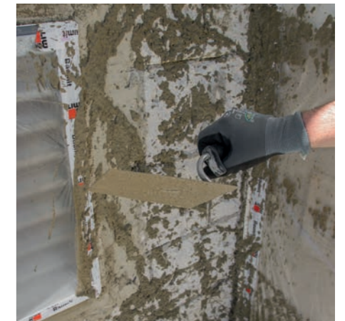
3 Saniervorspritzmörtel 50 % deckend aufbringen
