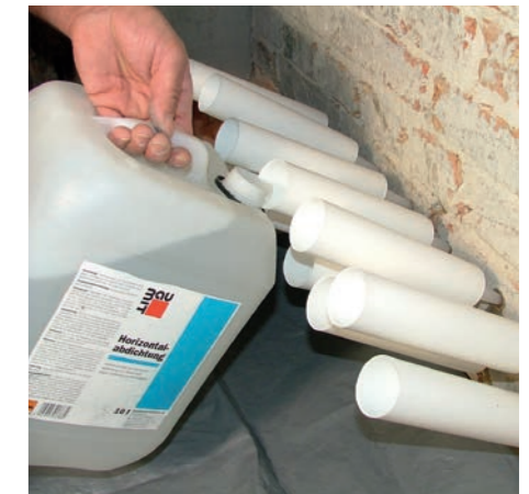
4 Einbringen der Horizontalabdichtung
