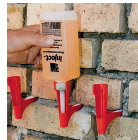
5 Aufsetzen der Bohrloch-Kartusche mit Injektionsflüssigkeit
